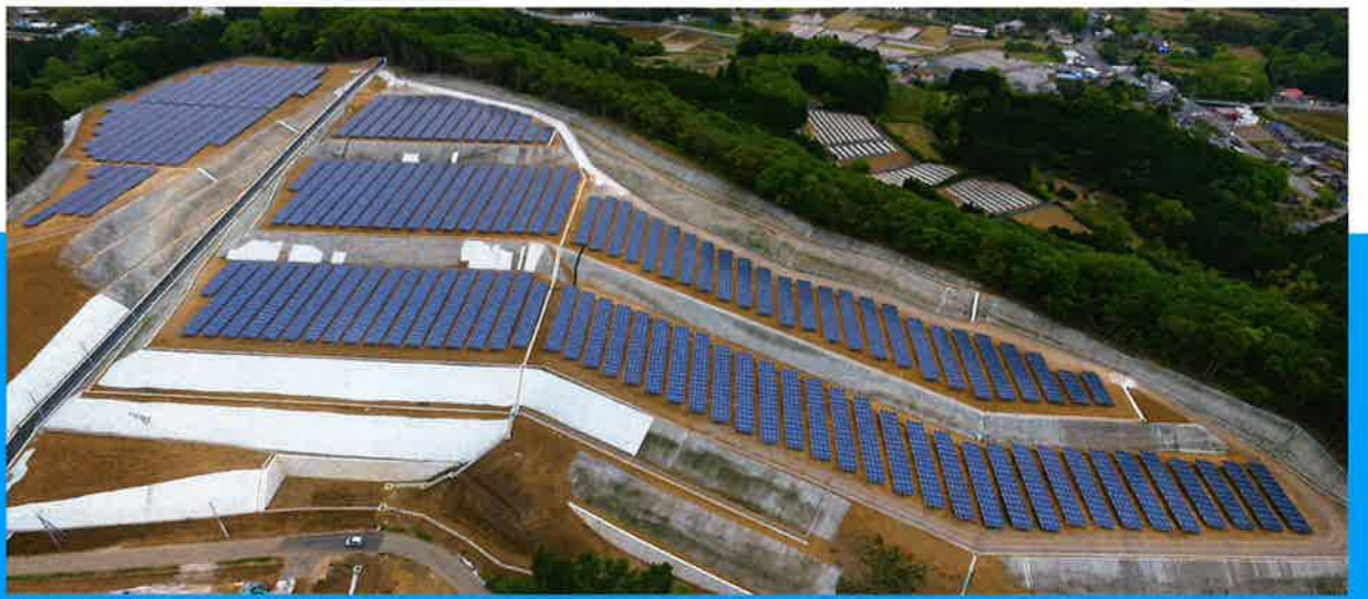
静岡県伊豆の国市浮橋太陽光発電所全景
